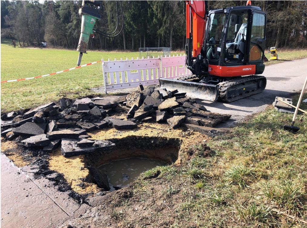
Abbildung 2: Situation am Verbruch nach dem Öffnen der Asphaltdecke. Das vollständige Ausmaß des Verbruches ist deutlich sichtbar.
