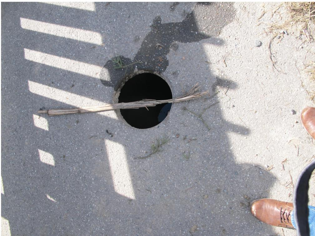
Abbildung 1: Situation am 25.02.2019; der Verbruch ist als kreisrunde Öffnung im Asphalt zu erkennen.
