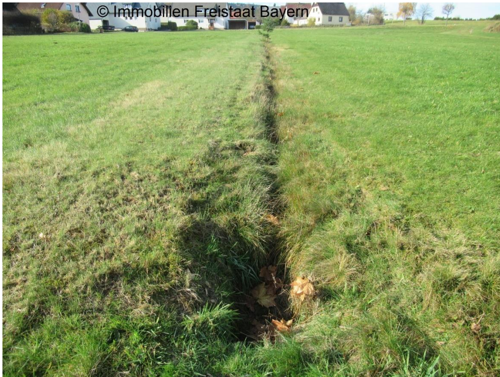
Entwässerungsgraben, Blick Richtung Westen.
