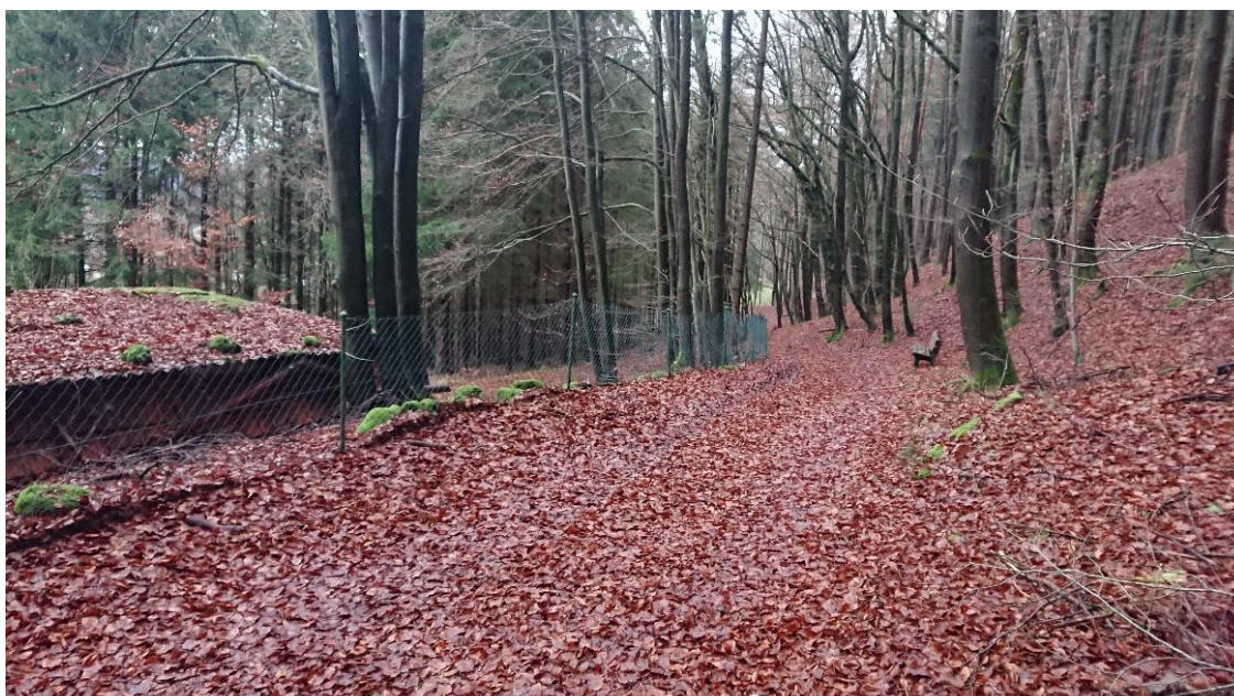
Ansicht Südseite von Südwesten
