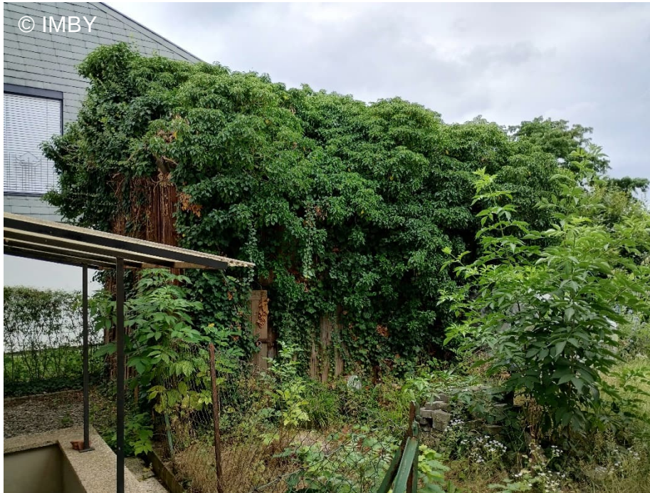
Holzschuppen (Ansicht auf dem Grundstück in östliche Richtung)
