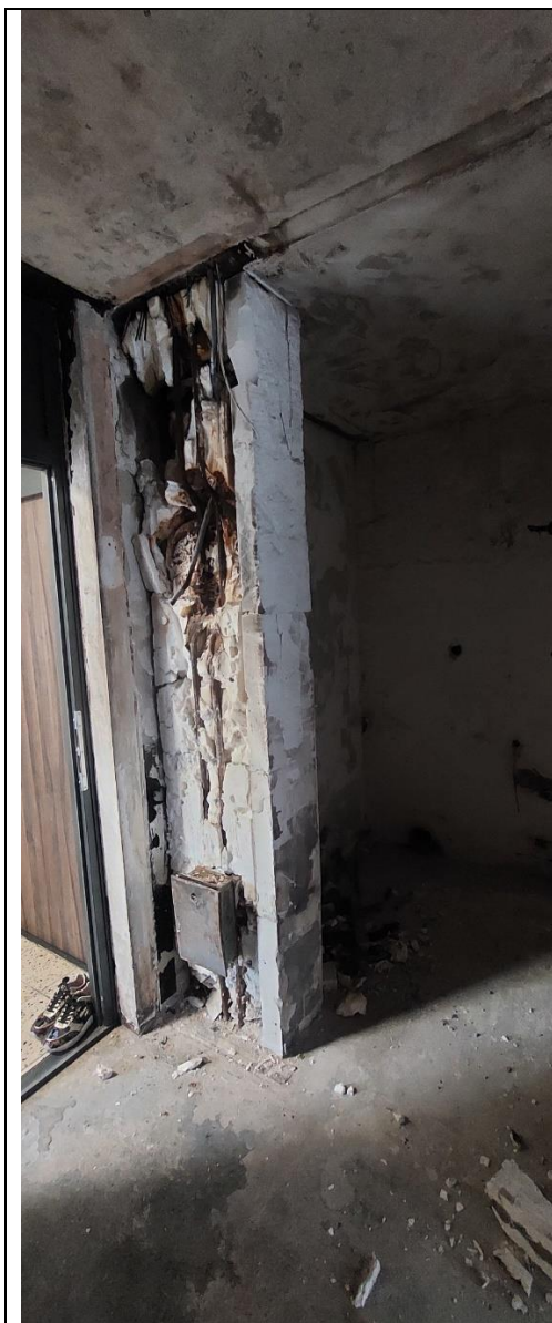
© IMBY – Innenansicht Flur, Bad
