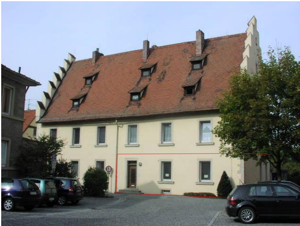
Hauseingang mit angedeuteter Mietfläche Foto: Immobilien Freistaat Bayern
