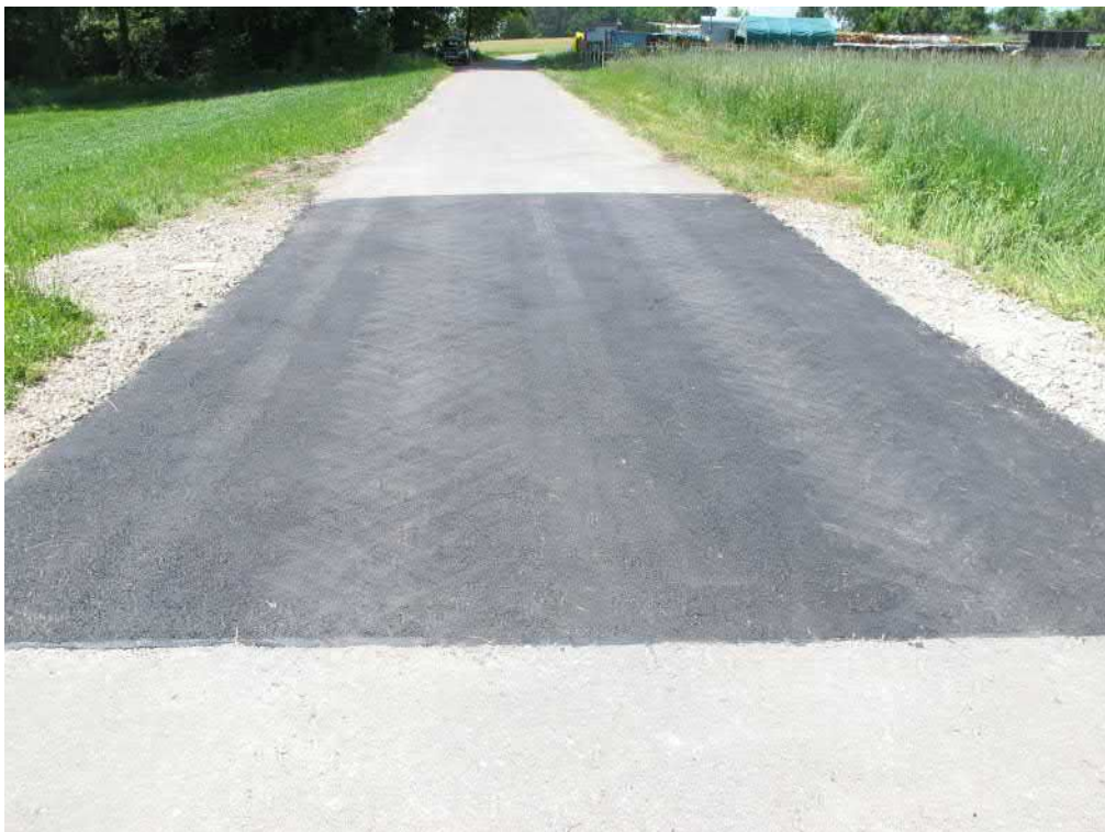
Abbildung 3: Wiederhergestellte Straße nach Abschluss der Sicherungsmaßnahme.
