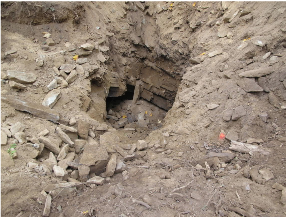
Abbildung 1: Beim Freilegen des ehemaligen Schachtkopfes angetroffener oberflächennaher Hohlraum.
