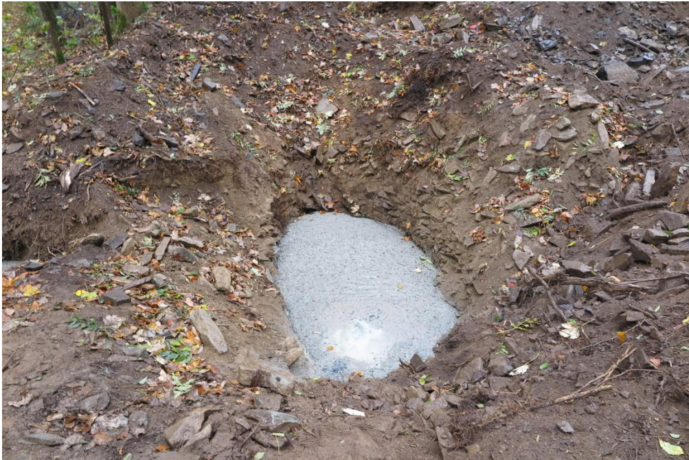
Abbildung 2: Oberflächennaher Hohlraum nach der Verfüllung mit Beton.
